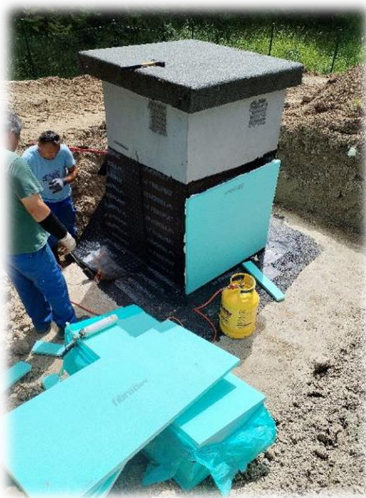
Izoliranje zračnikov
