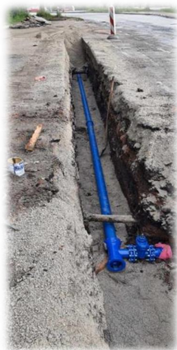
Izkop kanala, polaganje cevi in izdelava odcepa z zasunom
