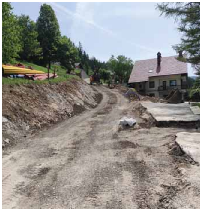
Rekonstrukcija dela ceste Hrib-Dednik
