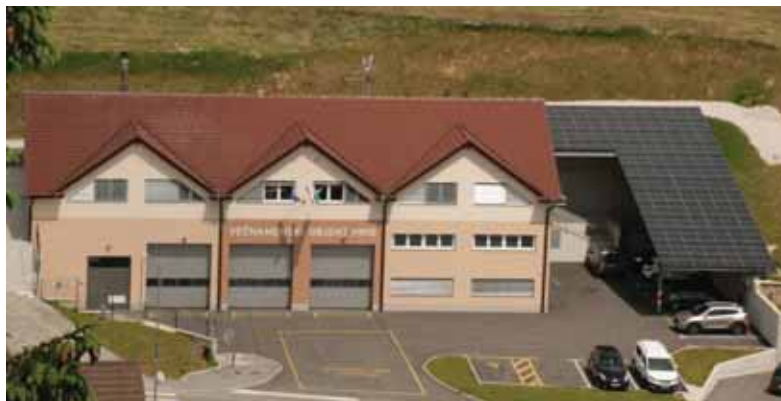
Kotlovnica je danes sestavni del večnamenskega objekta Hrib (vrata na levi strani objekta)
