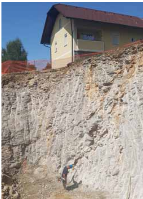
Izkop za zalogovnik za sekance (150 m 3 ), ki se nahaja pod kotlovnico
